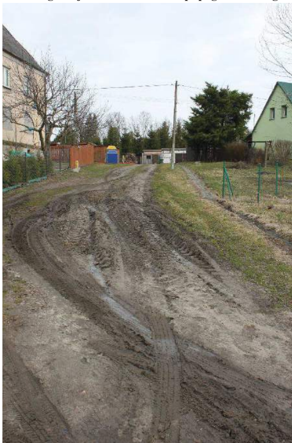
Fotografia 14 Droga dojazdowa do osiedla popegeerowskiego Nowe Siolo
