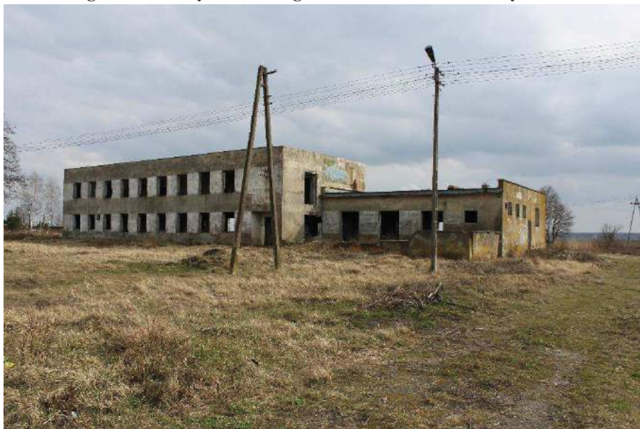
Fotografia 20 Budynek dawnego biurowca – Osiedle Stary Lubliniec
