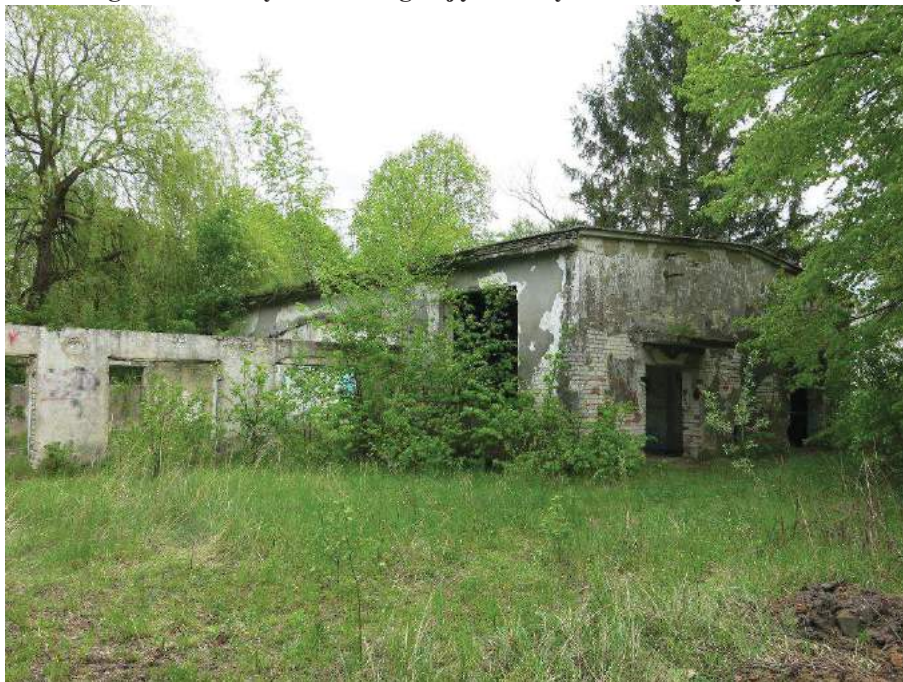
Fotografia 22 Budynek dawnego ujęcia wody – Osiedle Stary Lubliniec
