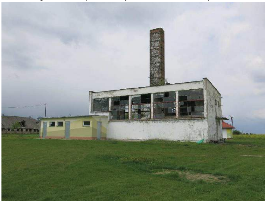
Fotografia 21 Budynek dawnej kotłowni – Osiedle Stary Lubliniec
