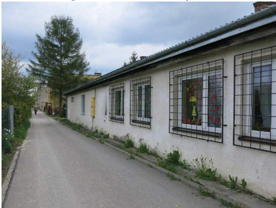
Fotografia 18 Świetlica – Osiedle Stary Lubliniec
